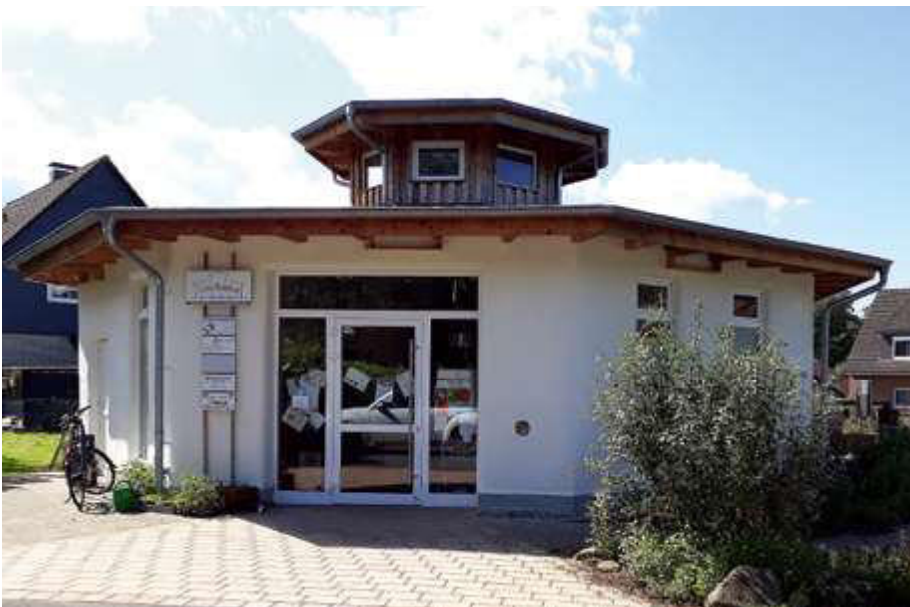
Der Dorfladen „Süntellädchen“ in Flegessen wurde von der Dorfgemeinschaft ohne Fördermittel gebaut.
