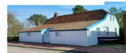
Abbildung 194: Krüppelwalm mit Dachabschleppung
