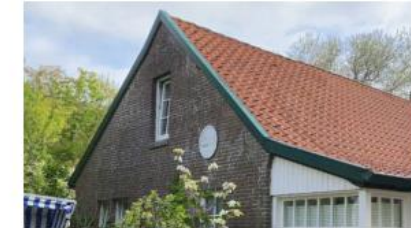
Abbildung 51: Satteldach mit Dachabschleppung
