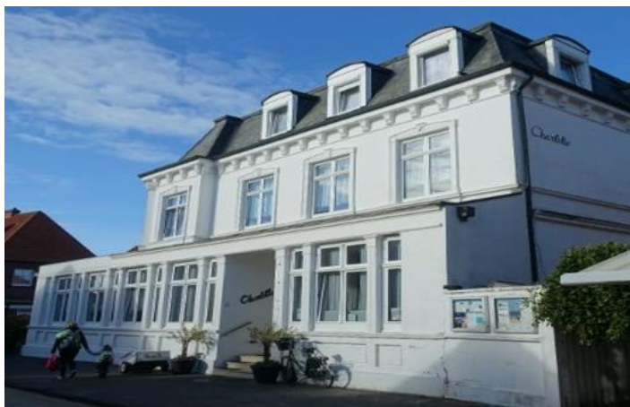
Abbildung 64: Vereinzelt Schieferdeckung und Verandadach (Denkmalschutz)
