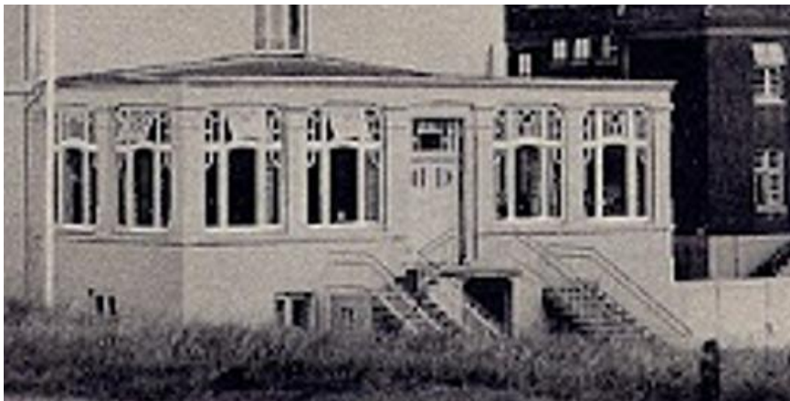
Abbildung 75: Historische Verandenfenster mit gemauerten Pfosten
