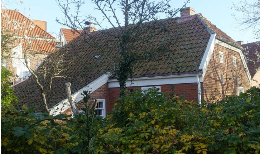
Abbildung 28: Eingeschossiges Backsteingebäude unter ziegelgedecktem Krüppelwalmdach, mit Anbau
