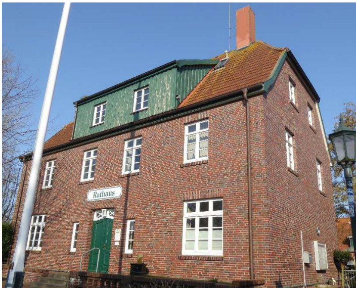
Abbildung 85: zweigeschossiger Klinkerbau mit Krüppelwalm und Schleppgaube
