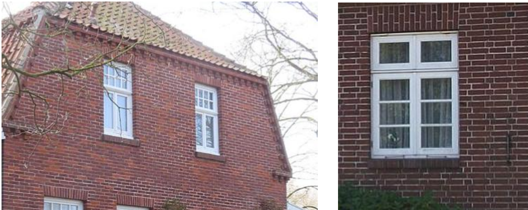
Abbildung 39: Beispiele für Ziegelmauerwerk
