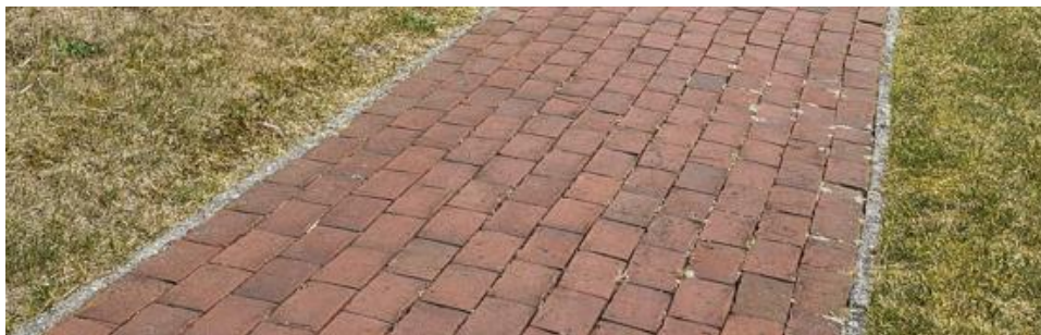
Abbildung 24: Weggestaltung – Pflasterung mit Ziegelsteinen
