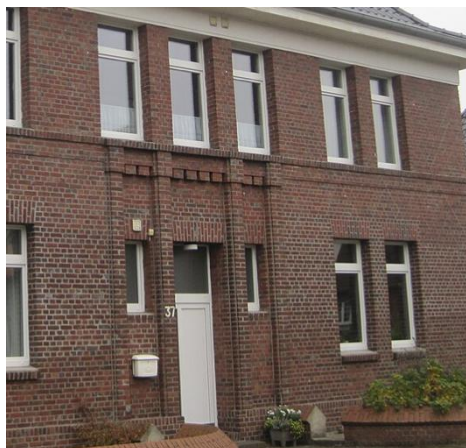
Abbildung 145: Ziegelornament im Eingangsbereich
