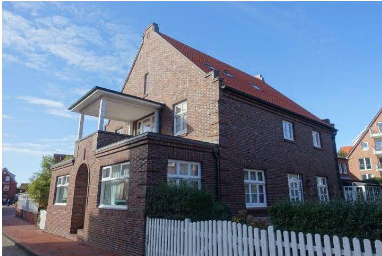
Abbildung 36: Wohnhaus um 1930 erbaut (Quelle: Denkmalatlas Niedersachsen)
