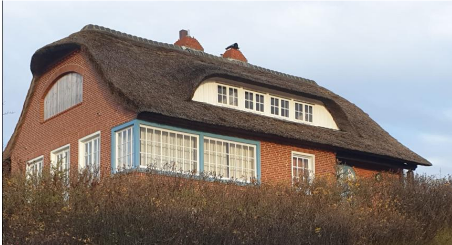
Abbildung 34: Massive Bauweise unter Reet (Krüppelwalm) in der Dünenstraße
