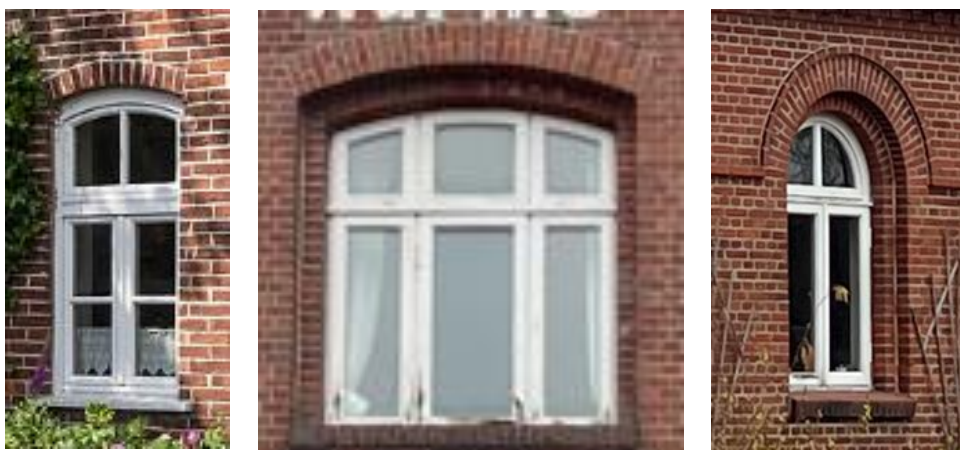
Abbildung 23: Beispiele für Fenster der Wohngebäude
