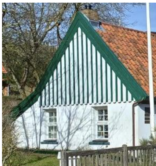
Abbildung 15: Verputzter Backsteinbau mit senkrechten Holzverschalungen im Giebel und Hebefenster
