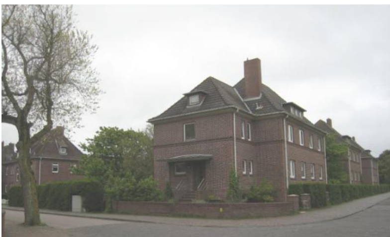
Abbildung 132: Zweigeschossiger Ziegelbau mit Walmdach und Schleppgauben Charlottenstraße / Rösingstraße
