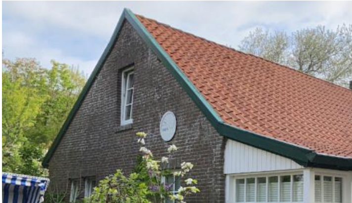
Abbildung 51: Satteldach mit Dachabschleppung
