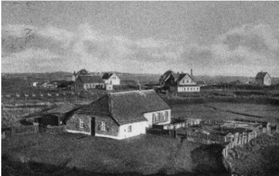
Abbildung 2: Gulfhaus (Wohn- und Wirtschaftsgebäude) aus der ersten Hälfte des 19. Jahrhunderts
