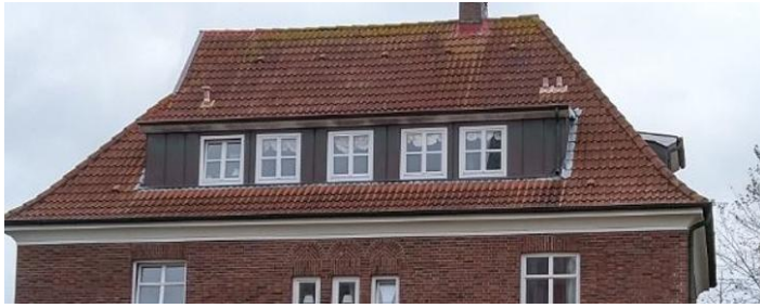
Abbildung 20: Walmdach mit weißem Gesimskasten
