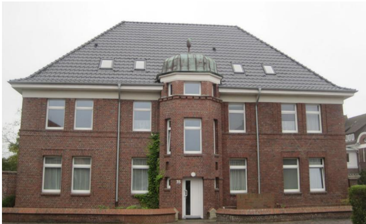
Abbildung 55: Ehemalige Kasernenanlage – polygonales Treppenhaus
