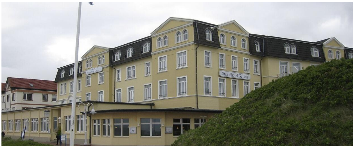
Abbildung 58: Denkmalgeschütztes „Strandhotel Gerken“ mit geschlossener Veranda (1891)
