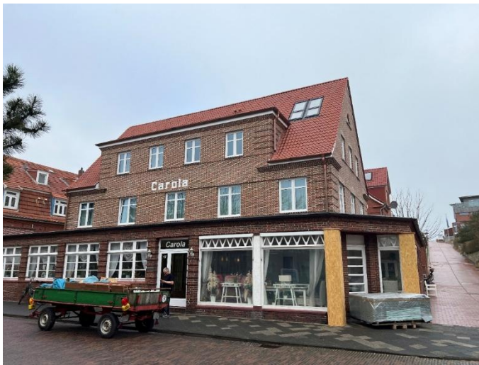
Abbildung 38: Wohn- und Geschäftshaus mit vorgelagerter inseltypischer Veranda
