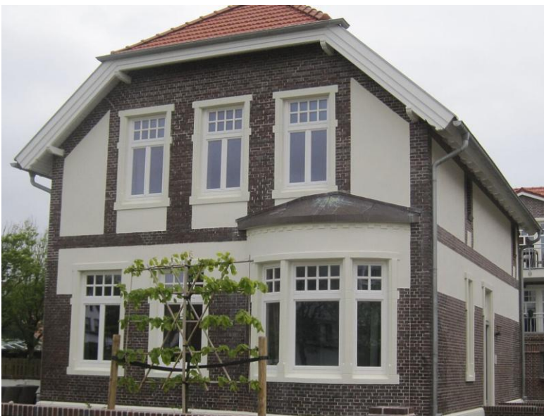
Abbildung 130: Denkmalgeschütztes Gebäude - ehemalige Schule
