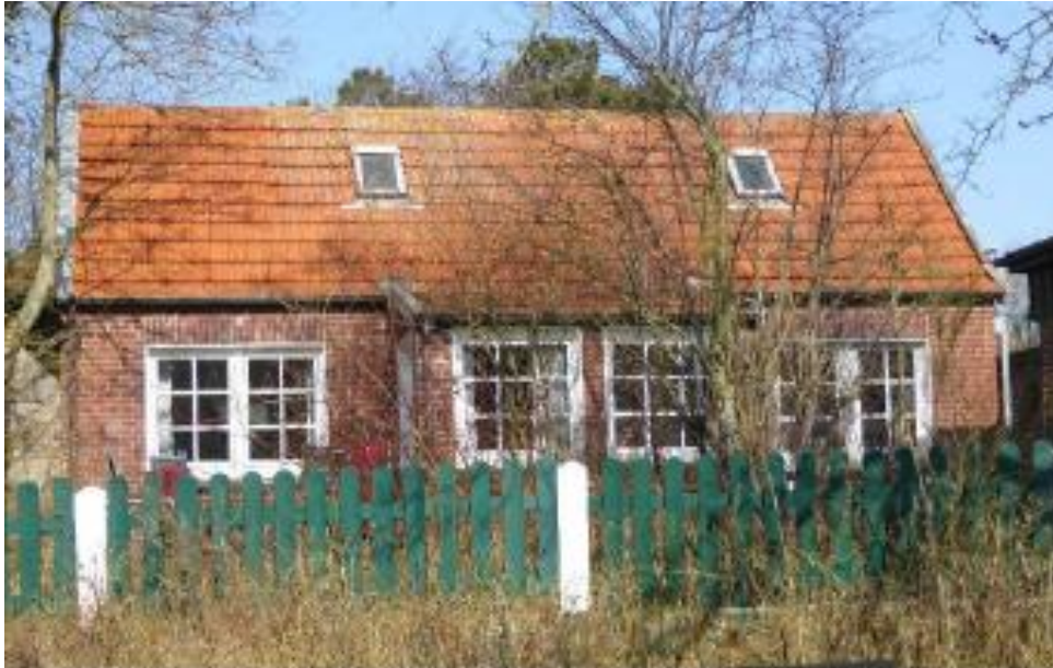
Abbildung 30: „Lütte Hütt“ mit Satteldach und Doppelmuldenfalzziegel, (Baujahr 1935)
