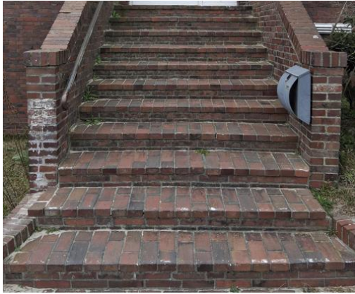
Abbildung 79: Eingangstreppe aus Ziegelsteinen
