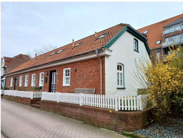
Abbildung 29: Wohnhaus „Haus Bredden“ eingeschossiges massives Doppelhaus
