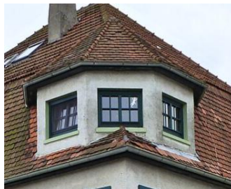
Abbildung 67: Turm auf Gebäudeecke mit Zeltdach
