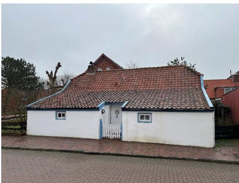
Abbildung 27: Insulanerhaus "Haus Heiken" unter ziegelgedecktem Krüppelwalmdach mit Anbau unter abgeschlepptem Dach (Anfang 19. Jhd.)
