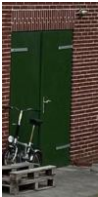
Abbildung 22: Tür / Tor im Nebengebäude
