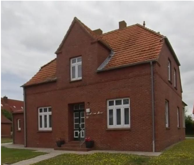
Abbildung 16: Wohngebäude mit Zwerchhaus
