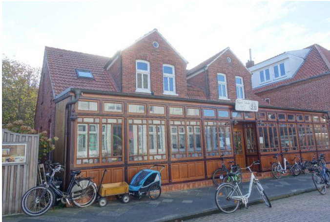
Abbildung 37: Wohn- und Geschäftshaus mit vorgelagerter inseltypischer Veranda
