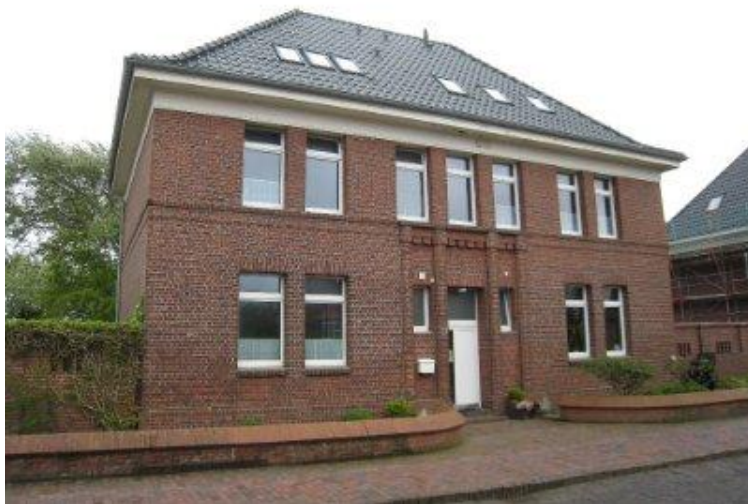
Abbildung 134: Ehemalige Kasernenanlage – Ziegelrahmung
