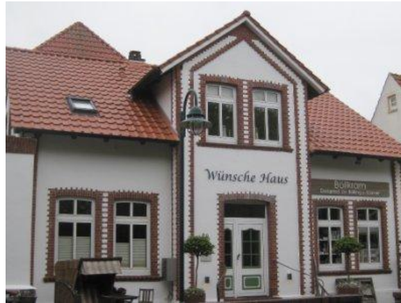
Abbildung 69: Erker mit Satteldach
