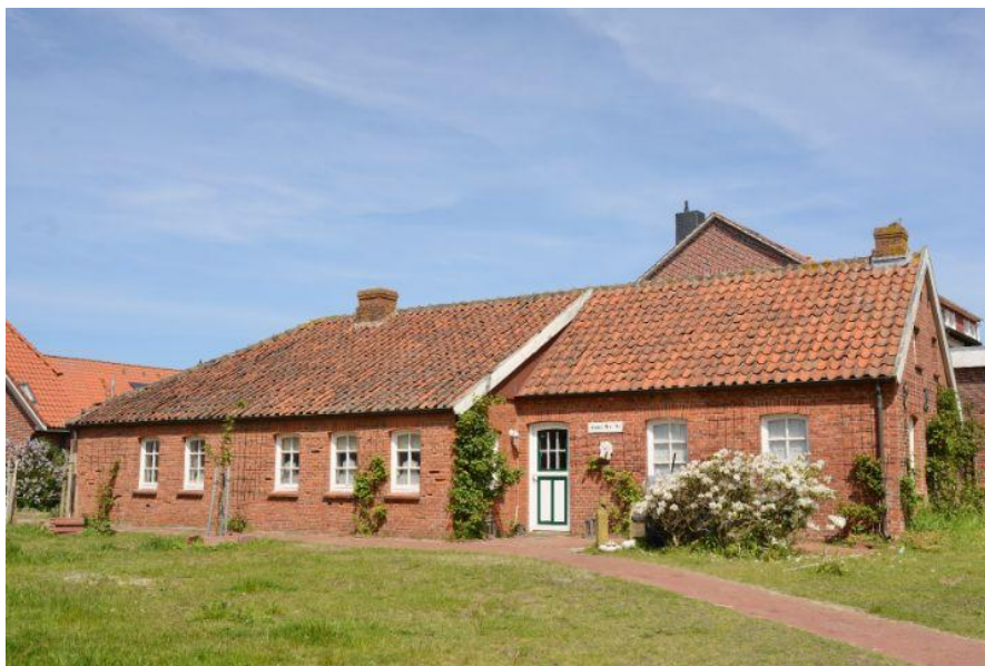
Abbildung 5: Denkmalgeschütztes Wohn- und Wirtschaftshaus erbaut Ende des 19. Jahrhunderts
