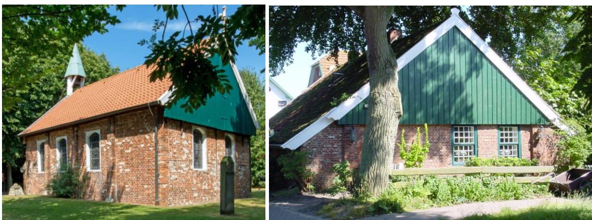
Abbildung 42: Das Schwimmdach der „Alten Inselkirche“ und am „Alten Inselhaus“
