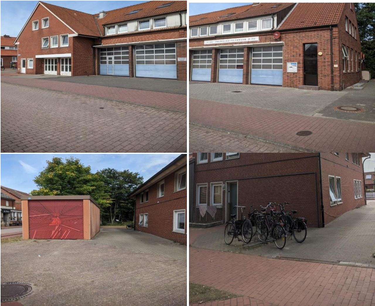
Fotos vom ehemaligen Feuerwehrgebäude
