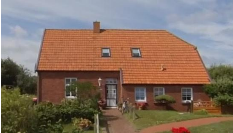
Abbildung 20: ehemaliger Wirtschaftsteil – rechte Gebäudeseite
