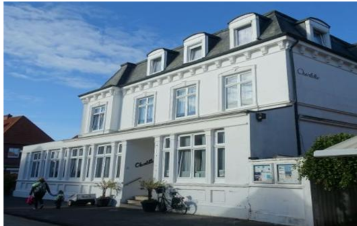
Abbildung 64: Vereinzelt Schieferdeckung und Verandadach (Denkmalschutz)
