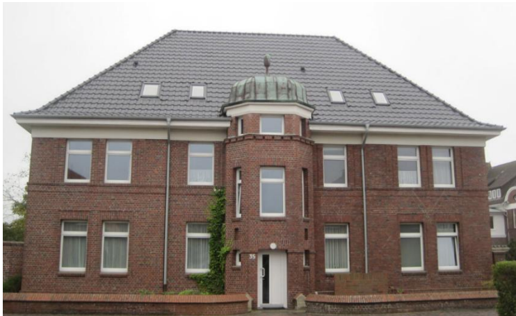
Abbildung 134: Ehemalige Kasernenanlage – polygonales Treppenhaus
