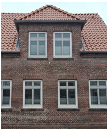
Abbildung 156: Zwerchhaus mit Walmdach
