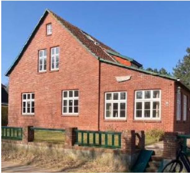
Abbildung 82: Wohnhaus mit massivem Anbau im Verandastil
