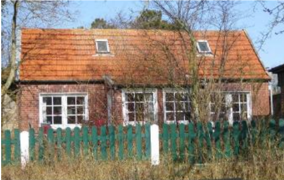
Abbildung 79: „Lütte Hütt“ mit Satteldach und Doppelmuldenfalzziegel, (Baujahr 1935)
