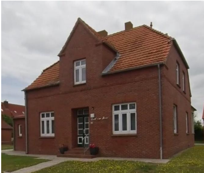
Abbildung 16: Wohngebäude mit Zwerchhaus
