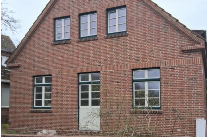
Abbildung 144: Gebäude mit Ziegelmauerwerk
