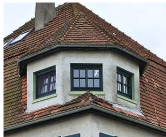
Abbildung 155: Turm auf Gebäudeecke mit Zeltdach
