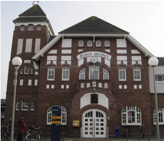
Abbildung 145: Putzelemente in Klinkerfassade
