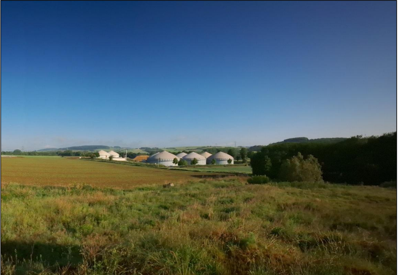
Abb. 4: Bioerdgasanlage (Blickrichtung Nordwest; eigene Aufnahme vom 23.05.2024)
