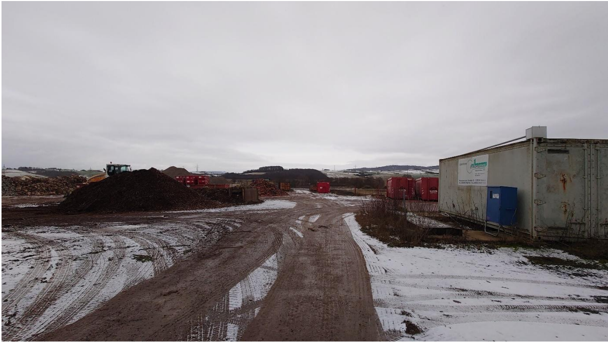
Abbildung 2: Blick von Süden auf das Plangebiet, Quelle: Planungsgruppe Puche 2024
