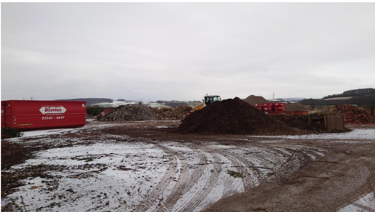
Abbildung 3: Blick von Süden auf das Plangebiet, Quelle: Planungsgruppe Puche 2024
